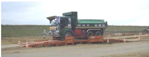
泥落装置「スパッツ」を設置して、タイヤについての泥を現場内で処理することにより、道路を汚さないように配慮しています。
