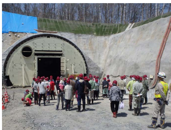
トンネル坑口に設置してある、音を低減する防音扉の説明を聞きました
