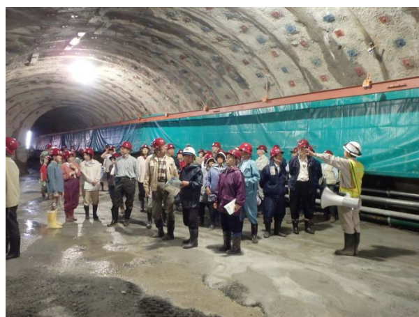
避難坑内にてトンネル掘削方法を聞きました
