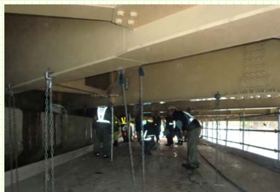
川口南大橋の現場点検(橋の下の様子)
