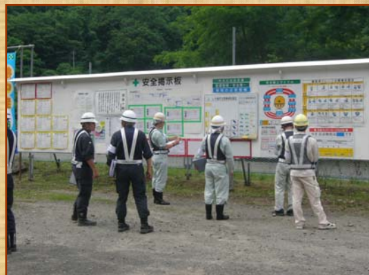
現場事務所点検
