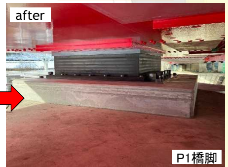
免震支承に交換
