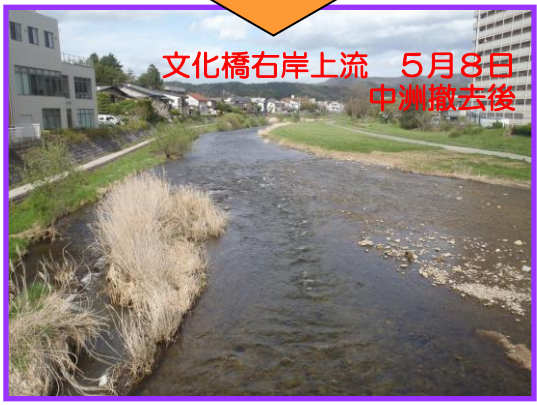
④中洲撤去 (文化橋)
