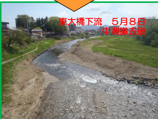
③中洲撤去 (東大橋)
