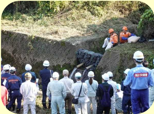
土のうによる下流拡散防止工の実演
