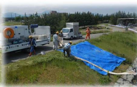
【抜き取りたい水側にポンプを入れて、吸い上げた水を河川に流します】
