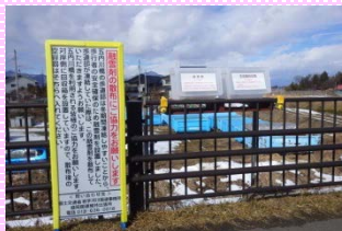
↑紫波町高水寺「五内川橋」の様子
