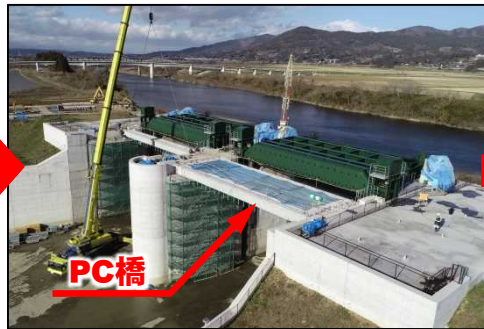
クレーンによる架設作業
