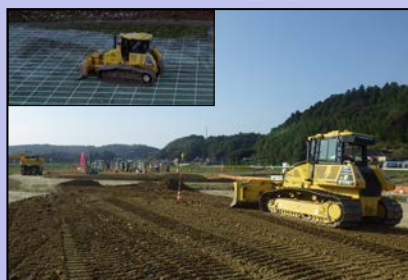
3D制御ブルドーザ作業
