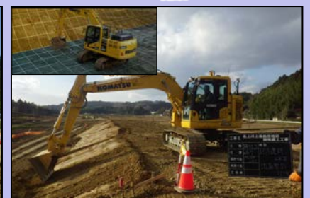
3D制御バックホウ作業
