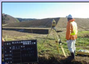
レーザースキャナー出来形測量
