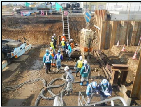
▲ 石畑排水樋管改築工事パトロールの様子
