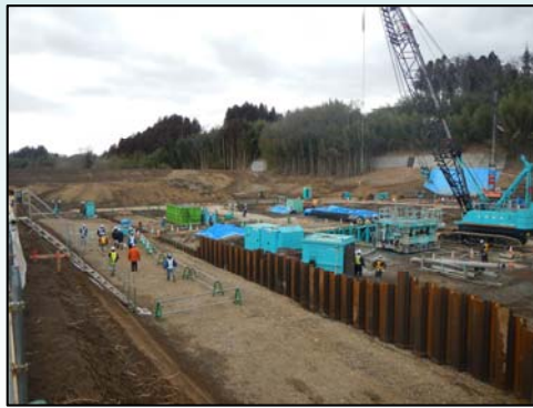
▲ 長島水門新設工事パトロールの様子
