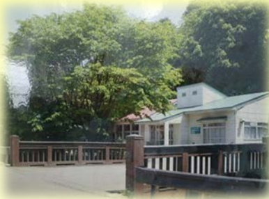
「北上川源泉からの最初の橋」
