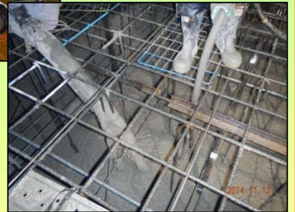
▼圧送された生コンを、バイブレータで締め固め
