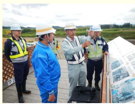
大林水門工事現場見学
