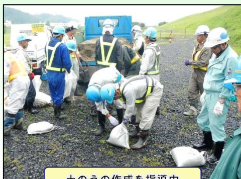
土のうの作成を指導中
