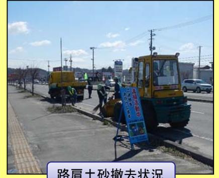
路肩土砂撤去状況
