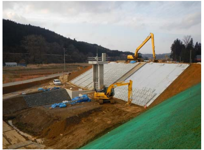
工事中の排水樋門と護岸
