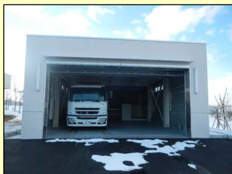
完成した格納庫。これにより防災及びセキュリティ面での向上が図られます。
