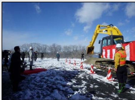
工事着工の号令により水門工事に着手
