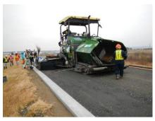
" アスファルトフィニッシャー" という機械を使って舗装していきます。この機械はドイツ製で一日に600mも舗装をすることが出来ます。
