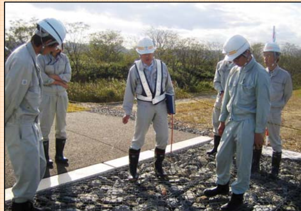
遊水地事業について説明(初期越流堤にて)
