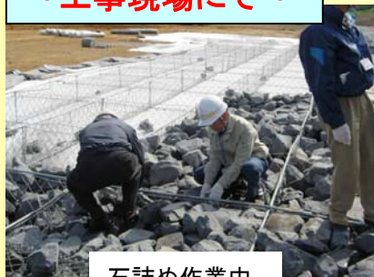
石詰め作業中
