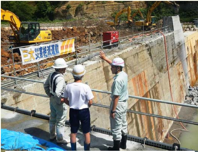
砂防現場にて工事の説明
