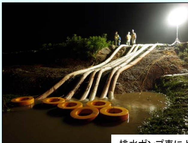
排水ポンプ車による内水排除の状況
