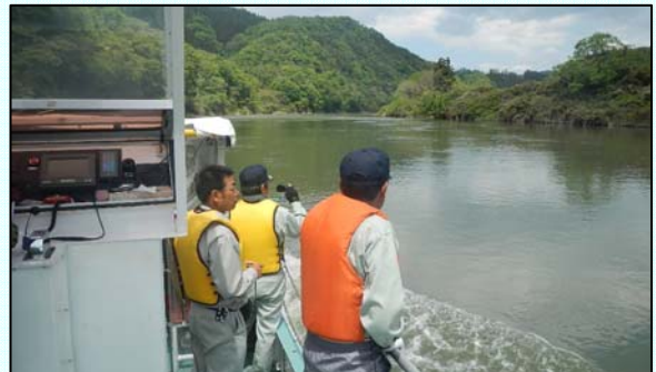
船上から護岸に異常がないかを確認
