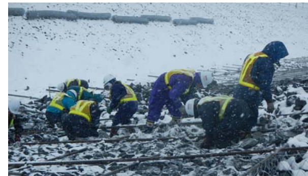
写真は、第1遊水地 八幡地区での「かごマット」の施工状況です。雪の降る中での工事が続きました。作業員の皆さん、地域のためにありがとうございました。
