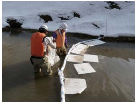
↑油は浮くので水面にオイルフェンスや油吸着マットを設置します。油が流れて来ている間は、何度も交換が必要になるため、高額な費用になる場合も・・・。
