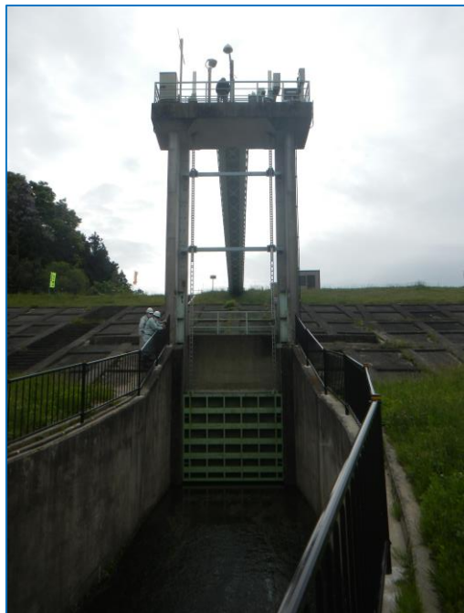
本郷排水樋管(北上川)
