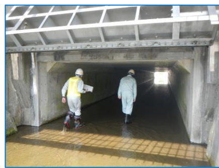
岩ノ下排水樋門(砂鉄川)
