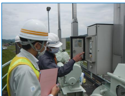
日形排水樋管(北上川)
