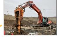
排水樋門施工箇所の地盤が 弱いので改良材を混ぜて地盤 を強くしています!
