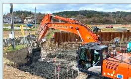
地盤改良作業
