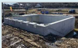
排水ピット全景
