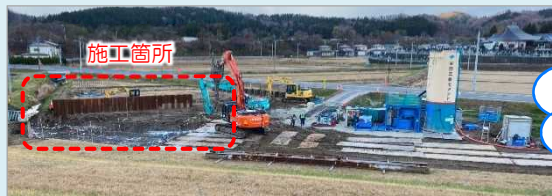
地盤改良のためのプラント
