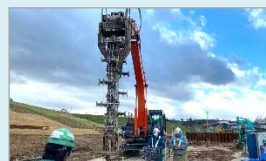
地盤改良機械 (パワーブレンダー)
