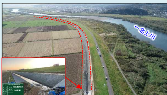
10月31日撮影 (施工中)
