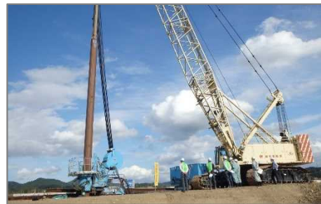
矢板打込施工見学
