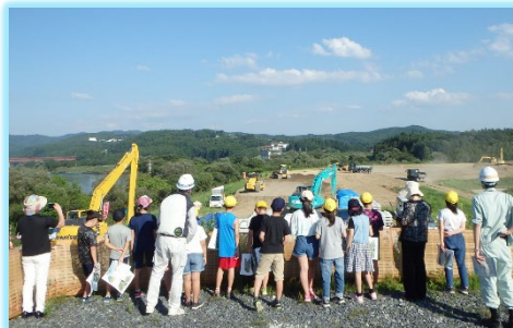
盛土施工を見学
