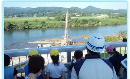
矢板打ち施工を見学
