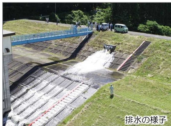
クレーンによる排水ポンプ設置の様子
