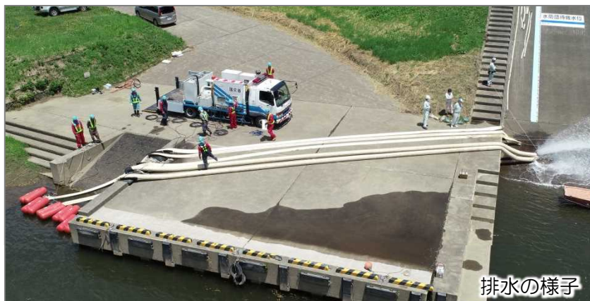
人力による排水ポンプ設置の様子
