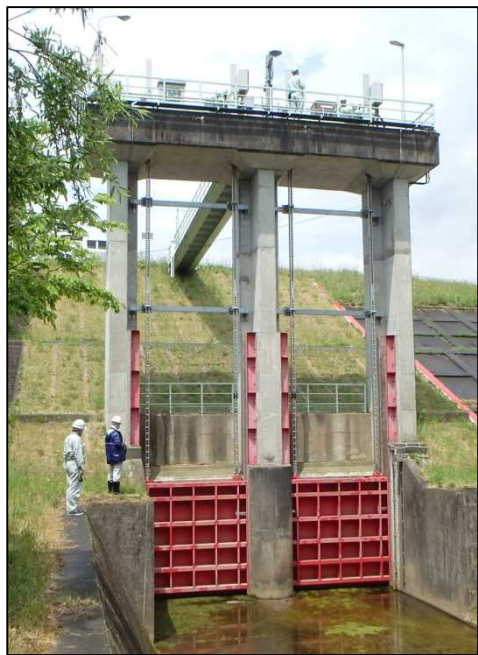
ゲート全閉確認
