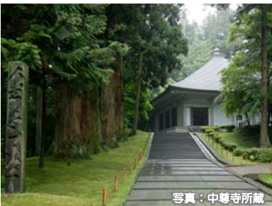
金色堂新覆堂 文化財保護のため、現在金色堂はコンクリート製の覆堂で囲われていて、ガラス越しに一面金色に輝く金色堂内部をみることができます。
