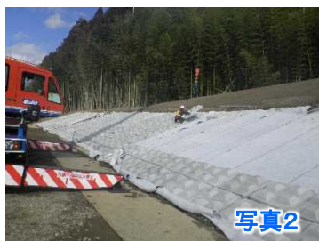
大型護岸ブロック設置
