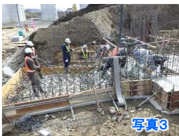
樋管本体内工鉄筋組立
