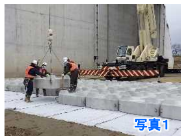
護床工ブロック設置
