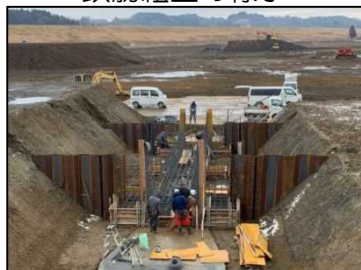
樋管設置工事 鉄筋組立の様子
