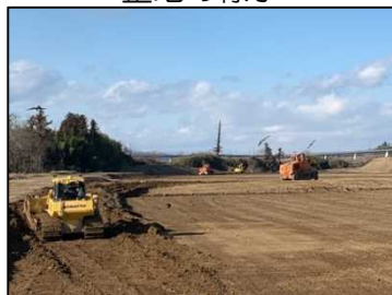
地内湛水地造成工事 整地の様子
