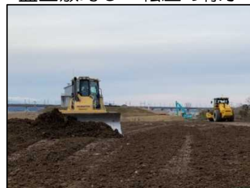
小堤築堤工事 盛土敷均し・転圧の様子
