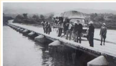
完成当時の鉄筋コンクリート橋
