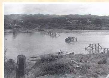
台風により流失した木造板橋
