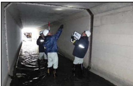
樋門樋管の点検
