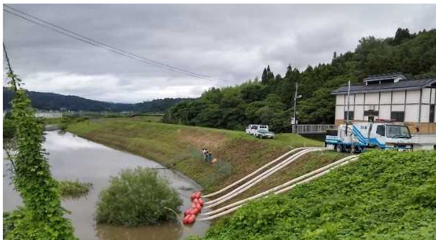
排水ポンプ車稼働(加妻川)左岸16km付近【一関市】
