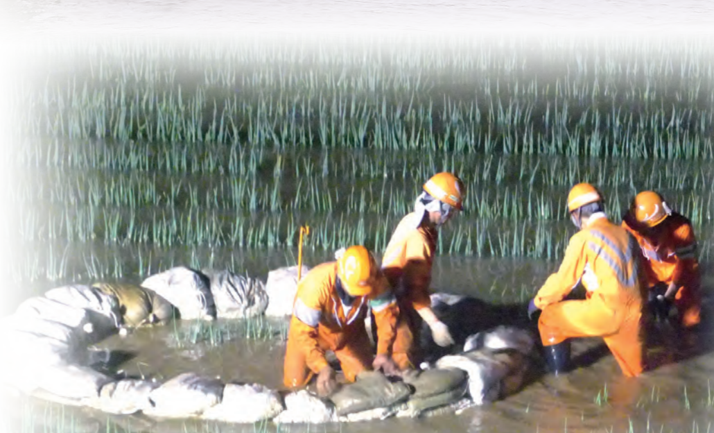
●釜段工法 (H25.8.9出水 矢巾町北上川水防活動)
