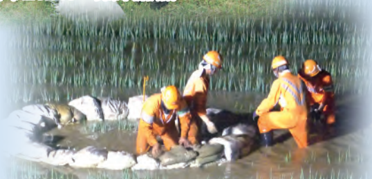
● 釜段工法 (H25.8.9出水 矢野町北上川水防活動)
