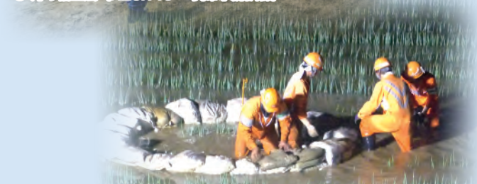
● 釜段工法 (H25.8.9出水 矢野町北上川水防活動)
