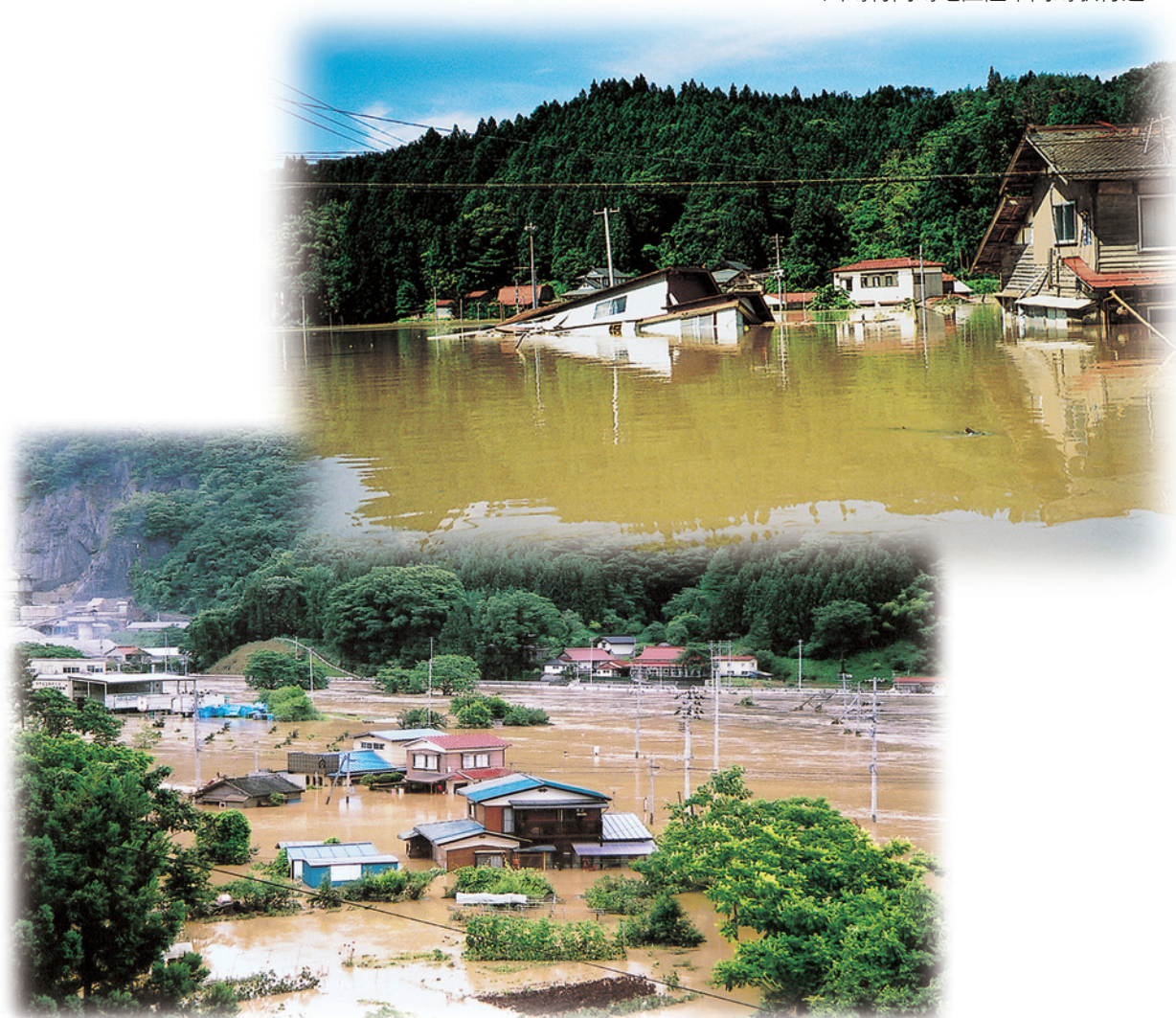
東山町松川地区浸水状況
