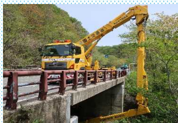
▲国交省所有のバケット式点検車による点検
