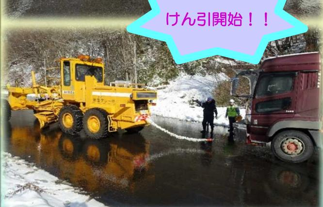
12月20日（金）、大雪によるスタック車両排除に備え、坂本山駐車帯にて、スタック車両を引き上げるためのワイヤー装着とグレーダーでのけん引訓練を実施しました。例年、山間部ではタイヤチェーンを装着していない大型車両のスタック発生がみられます。スタック車両の発生は後続車両だけでなく、対向車両への通行障害などの危険もあります。山間部では降雪量も多く、凍結しやすいので、早めに万全の対策をとったうえで「仙岩峠」越えをされますようお願いいたします。
