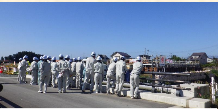
茂井羅南堰をまたぐ橋梁(本線橋)の下部工事を側道側より見学中です。
