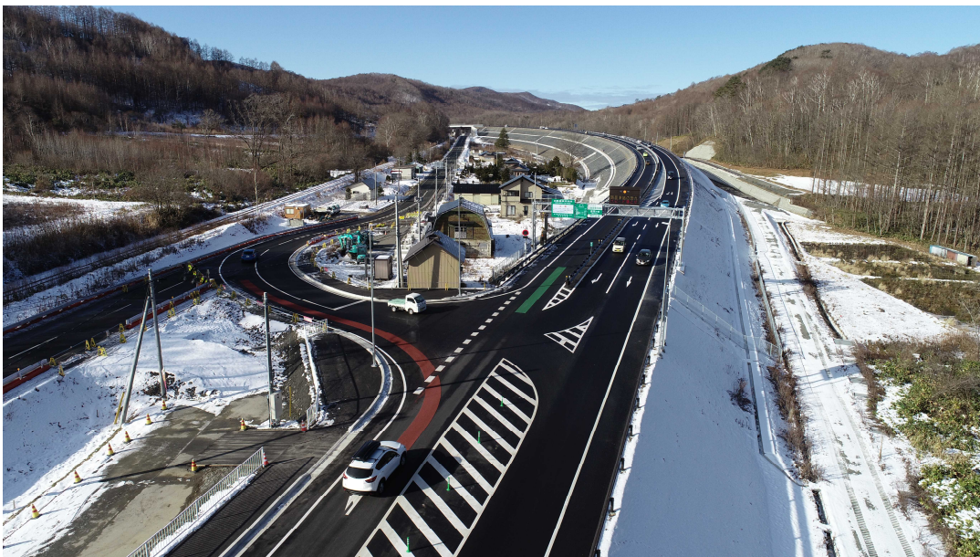
起点側（ドローン）
